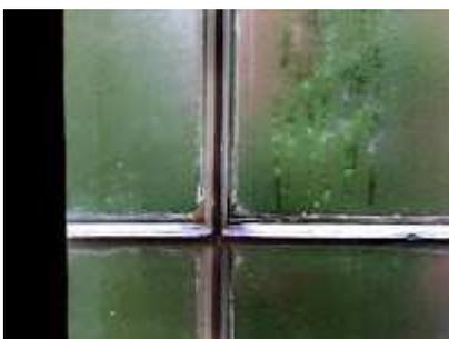
Ce rapport est généralement exprimé en pourcentage. Si par exemple on a une pression de vapeur d'eau de 0,7 atmosphères à une température de 100 degrés centigrades, en sachant que, à cette température la pression de vapeur saturée est exactement une atmosphère, la relation entre la pression de vapeur et la pression de vapeur saturante est  $0,7 / 1 = 0,7$ ; si cette fraction est exprimée en pourcentage est obtenue une valeur d'humidité relative de 70%.
